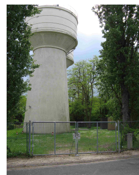
Château d'eau Rue Collinet
